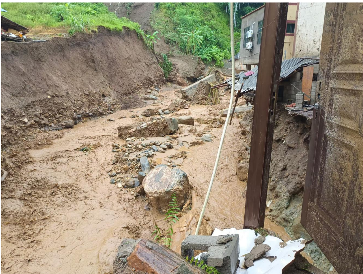
图 7 灾后房屋倒塌
