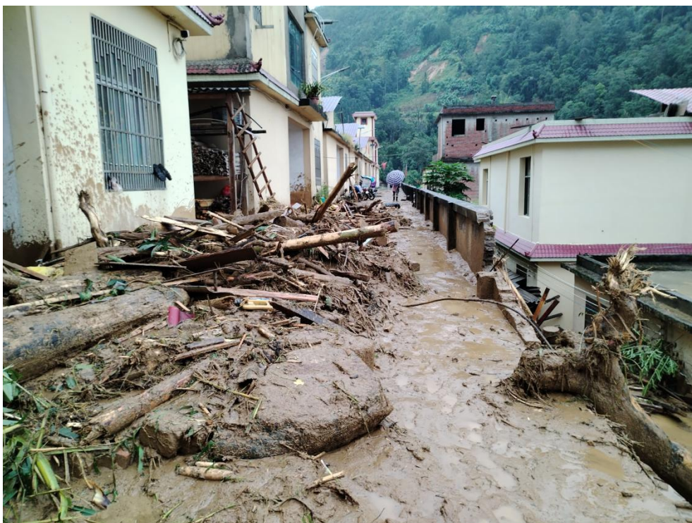
图 4 瓦窑新村灾后房屋受损
