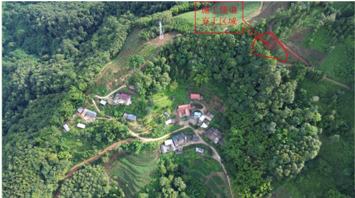
附图 1：2024 年 7 月 18 日灾害发生前的汛中巡查无人机拍摄照片
