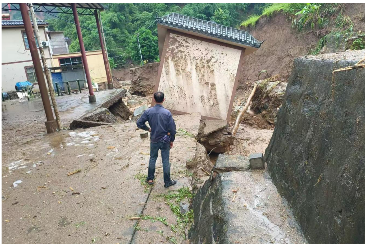
图 8 灾后房屋倒塌
